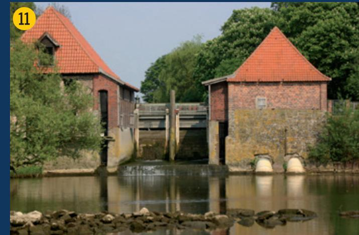
**Die Füchtelner Mühle** – malerisch und im Nebenfluss als kleines Wasserkraft-Werk genutzt. Durch den Bau einer Umflut ist hier 2015 die Durchgängigkeit der Stever für wandernde Fische wieder hergestellt worden.
