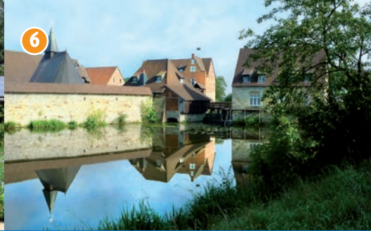
6 Burg Kakesbeck - Eine bereits im Mittelalter erwähnte, vielfach umgestaltete Wasserburganlage (in Privatbesitz - Besichtigung nur nach Anmeldung).
